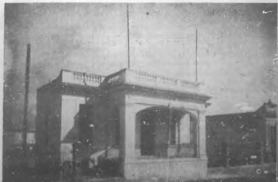
Fachada de la nueva casa del "Cuba Tennis Club", que próximamente se inaugurará.
